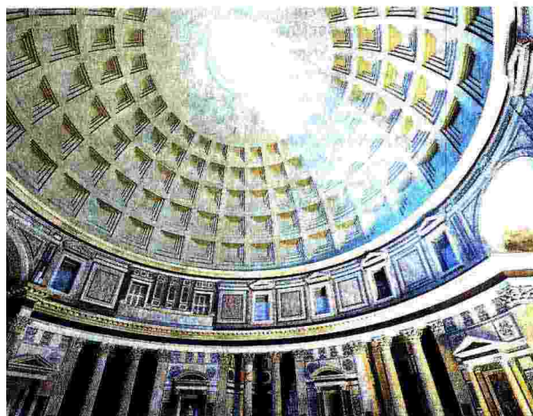
Pantheon L'attuale edificio è frutto del rifacimento di Adriano
